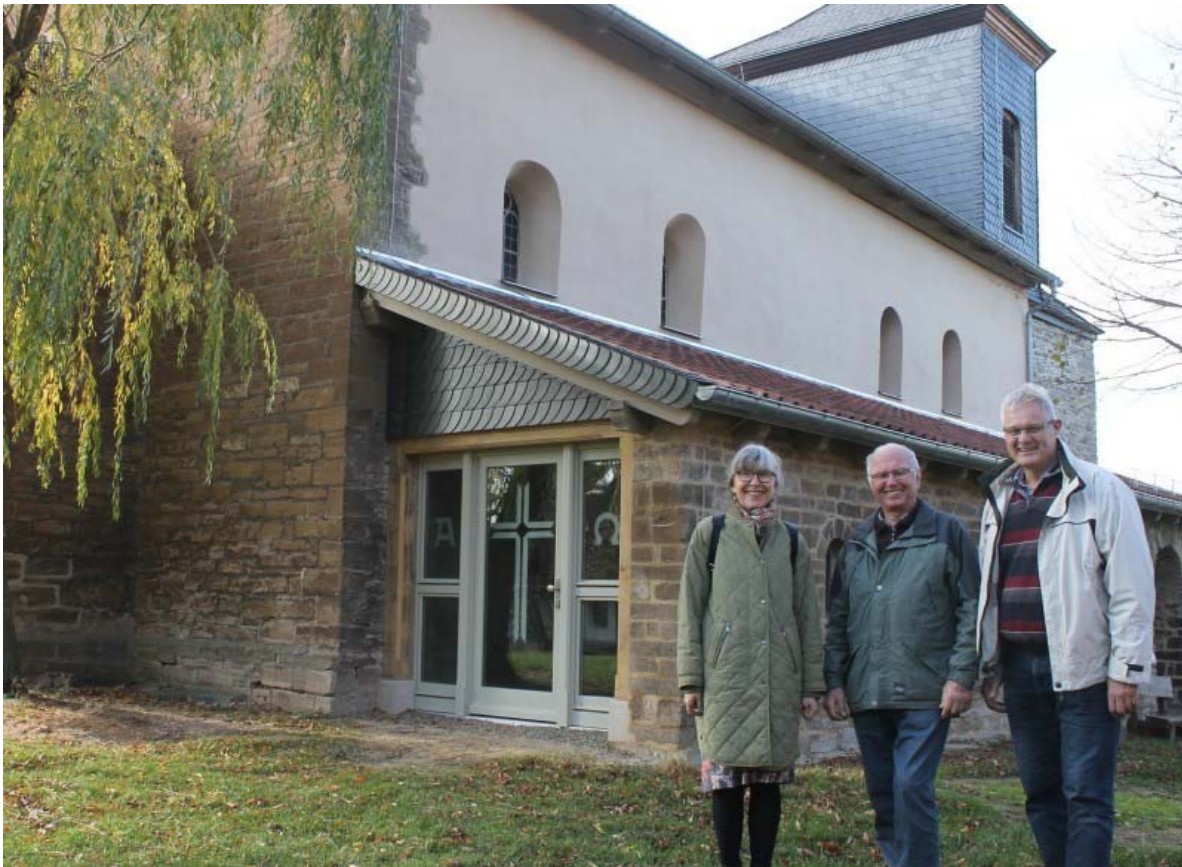
Pfarrerin Ulrike Hackbeil, Erhard Niehoff und Stephan Schädel (von links) vor der nun komplett sanierten Katharinenkirche im Darlingeröder Ortsteil Altenrode. Foto: Jörg Niemann
